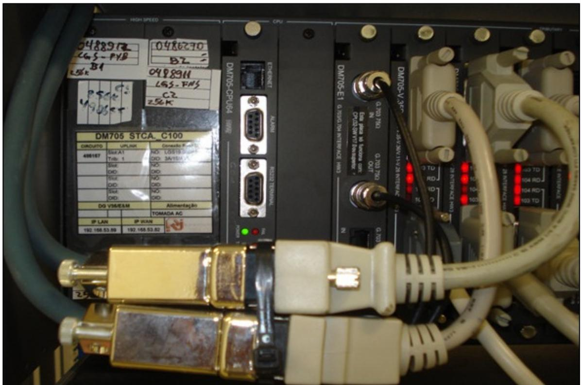
Figura 38. Multiplexador da Operadora – Detalhe da conexão serial.
