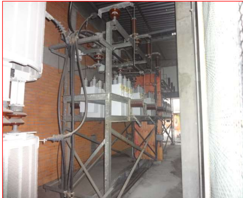
Figura 11: Bancos de capacitores em média tensão.
