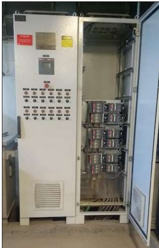
Figura 25: Cubículo banco de capacitores.
