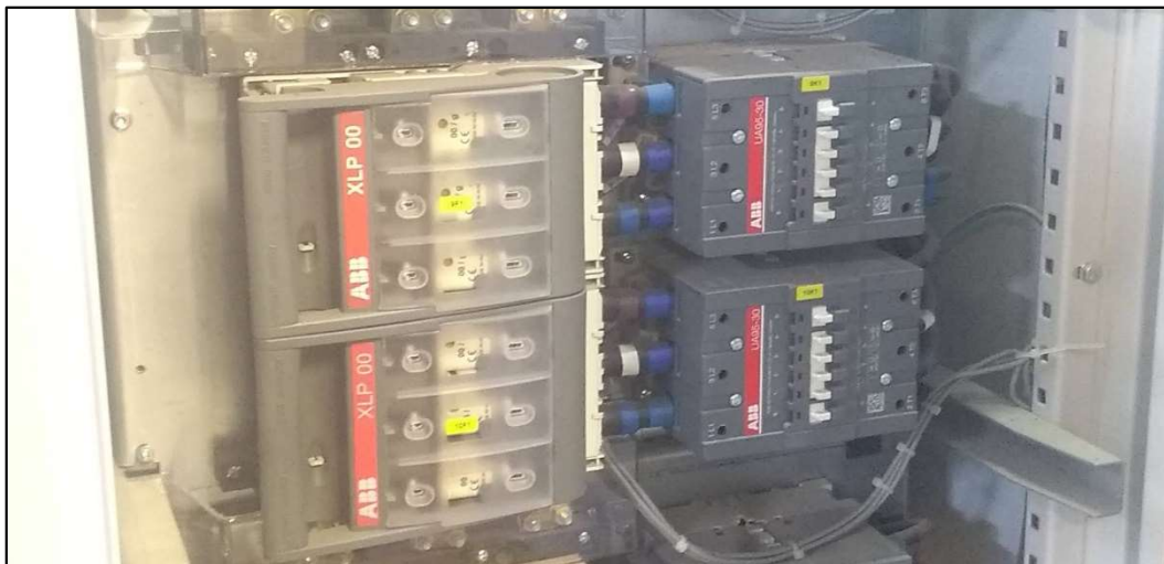
Figura 24: Fusíveis de proteção e contator utilizados.
