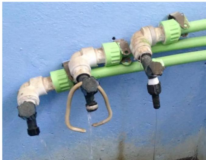
Na figura 06 nota-se uma marcação na torneira do filtro 2. Esta marcação indica de qual filtro está sendo coletado 100mL de amostra de água a cada 2 horas e depositado num frasco de vidro, para ao final da tarde ser realizada a análise de matéria orgânica.
