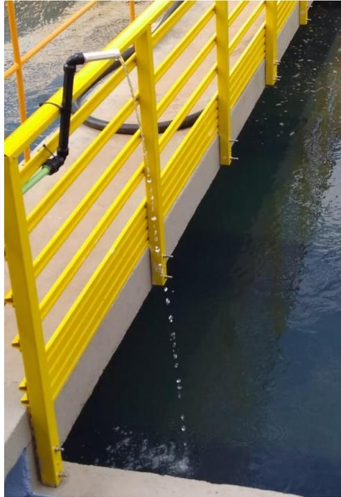
A água filtrada foi coletada em torneiras nas saídas dos filtros, onde ficam três torneiras vistas na figura 06, sendo, da esquerda para a direita, filtro 1, filtro 2 e filtro 3 (figura 06).
