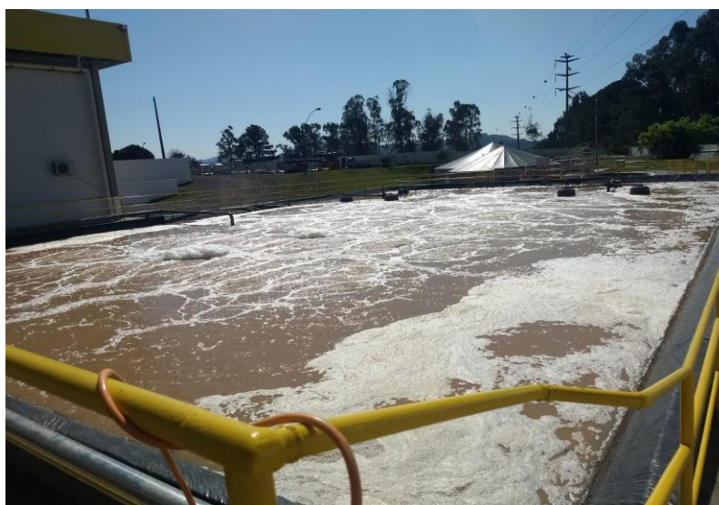
Figura 15- Lagoa de aeração 2
