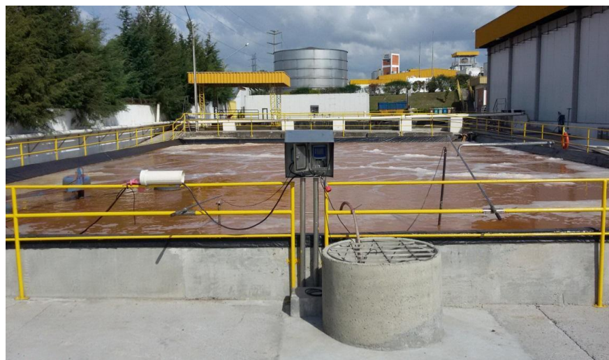
Figura 10- Tanque de aeração 2
