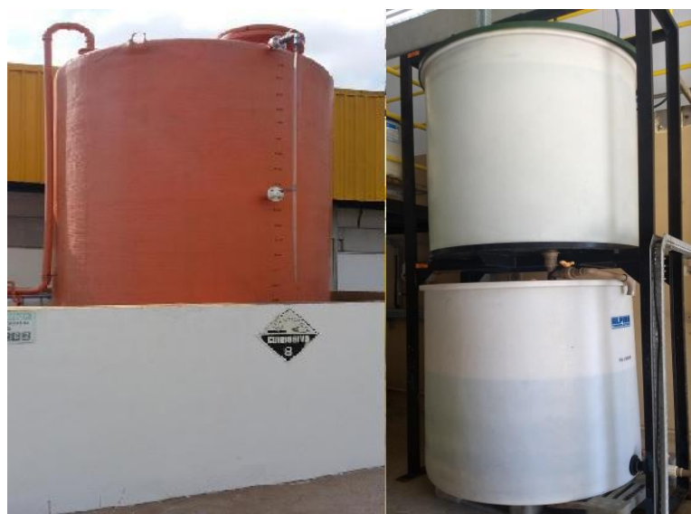
Figura 8- Tanque de cloreto férrico e polímero aniônico, respectivamente
