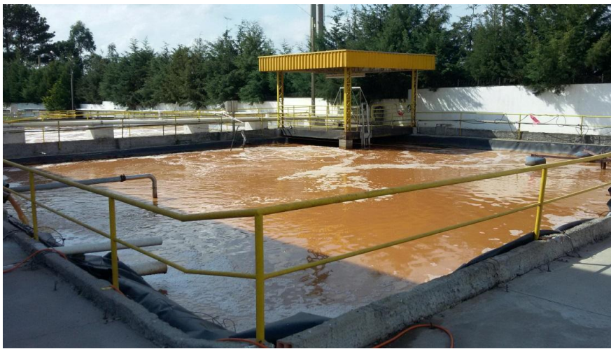
Figura 9- Tanque de aeração 1
