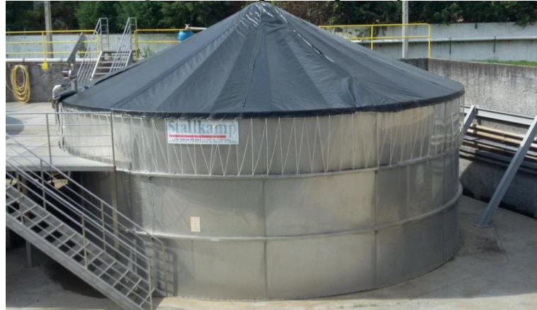
Figura 6- Tanque de equalização
