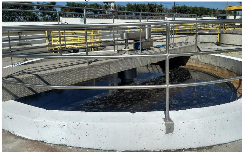
Figura 11- Decantador
