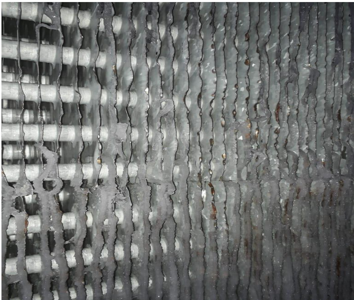
Figura 20: Bateria Número 2 desobstruída, após automatização do sistema de degelo.
