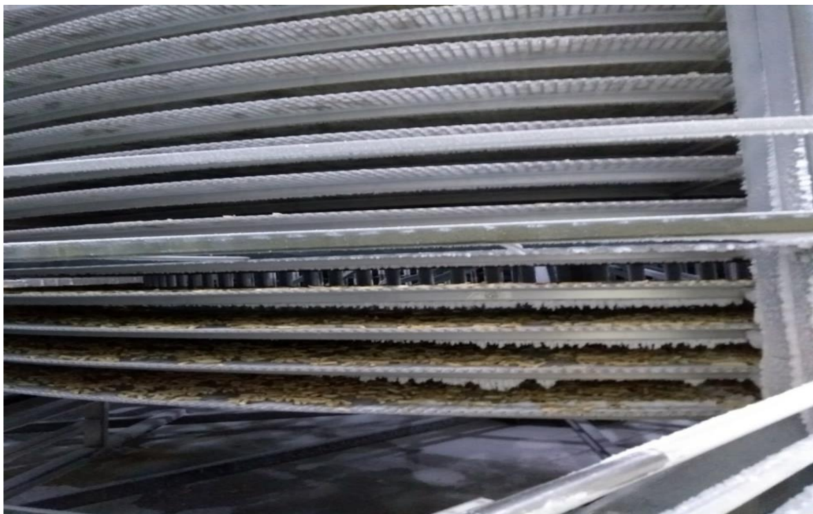
Figura 3- Esteira em inox do Giro Freezer 1 .
