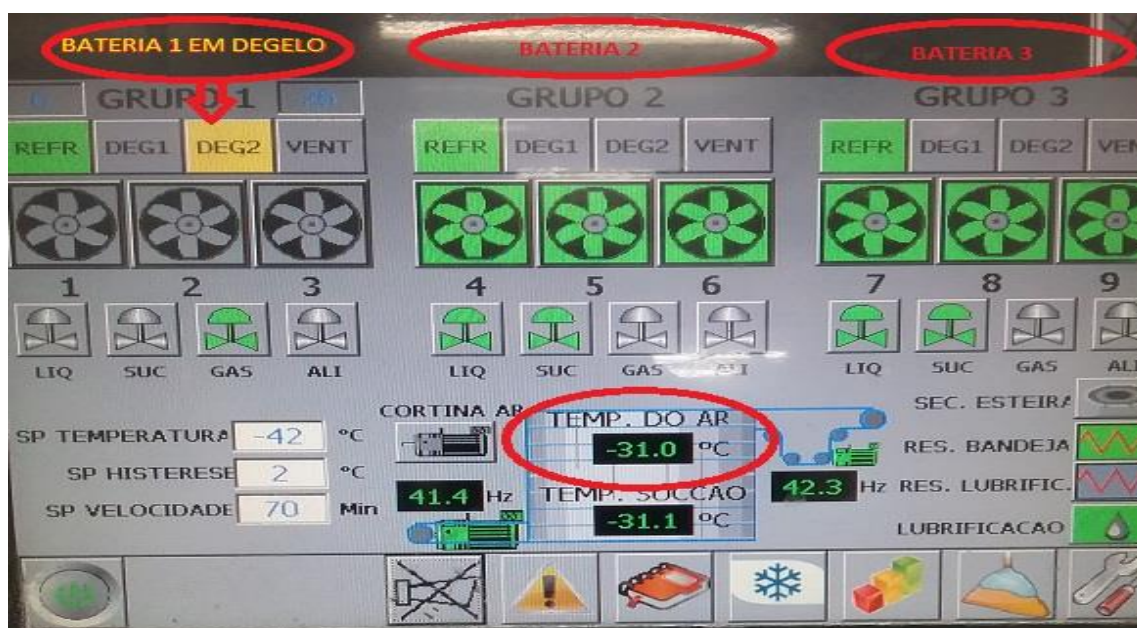
Figura 18: Painel de Controle do Giro Freezer em Processo de Degelo na Bateria 1
